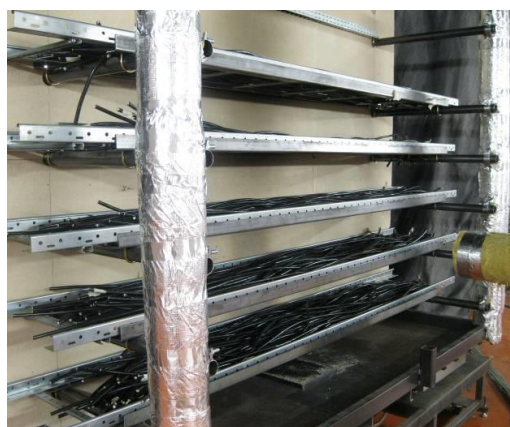
Figure 1 : Dispositif d'essai composé de cinq chemins de câble horizontaux.
